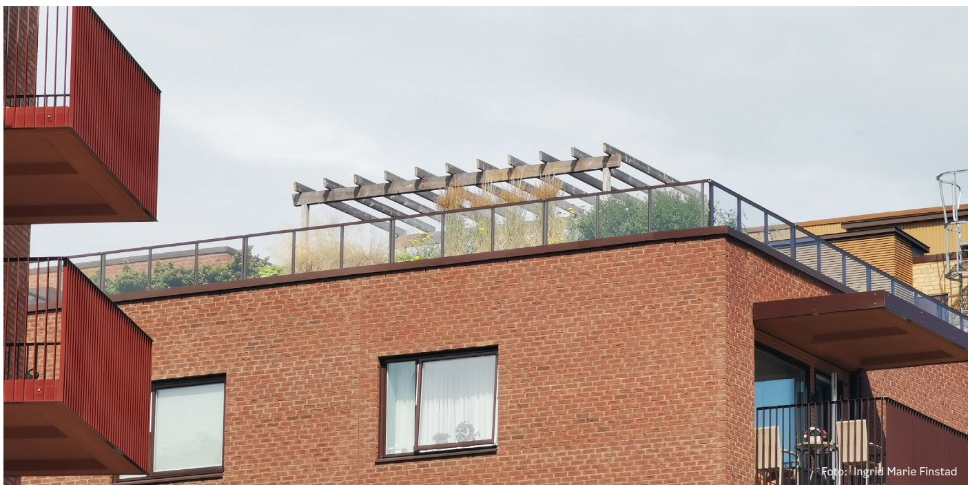
Grønt tak i Brobekkveien.
