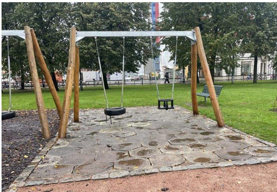
Figur 12 Inspeksjon av fallunderlag under testperioden, den 7. oktober 2025. Det regnet på dagen, og dagene i forkant var det mye regn. Foto: Oslobygg KF
