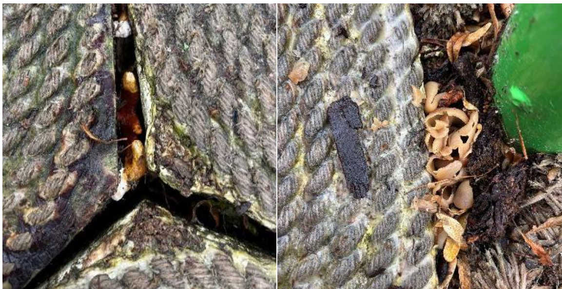
Figur 9 Bilder av observert soppvekst på fallunderlaget Baremark. Foto: Oslobygg KF
