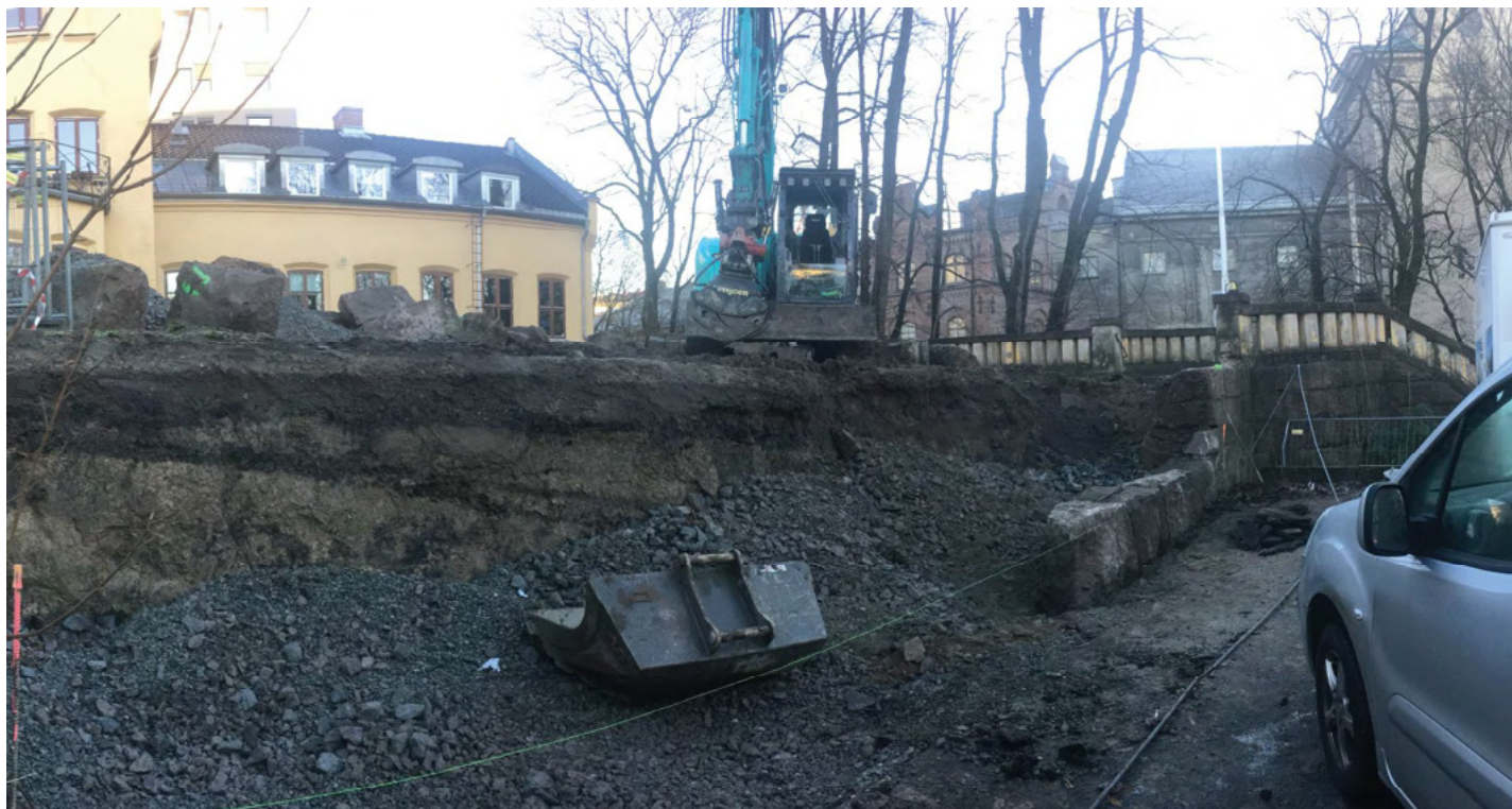
Historisk mur under restaurering, ved parkeringsplass, foran "Ole Amundsens Villa" Foto: B&L, September 2020
