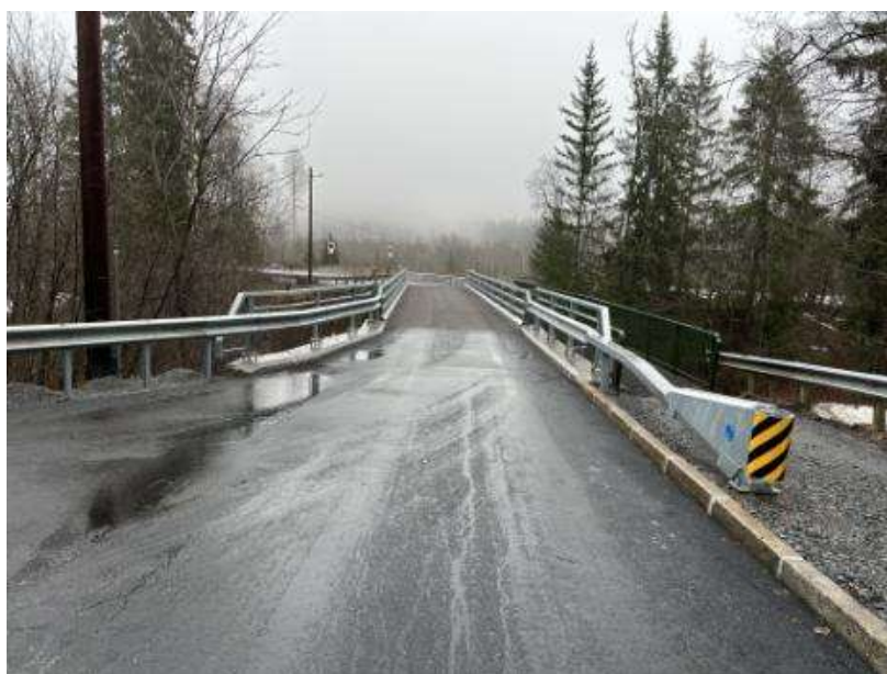
Figur 5-2: Eksisterende Åmot bru (midlertidige bru). Bildet er tatt mars 2024. (Aas Jakobsen, 2024)
