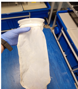
Figur 1: Finmaskede filtre for gulvavløpet på fiskerommene.
