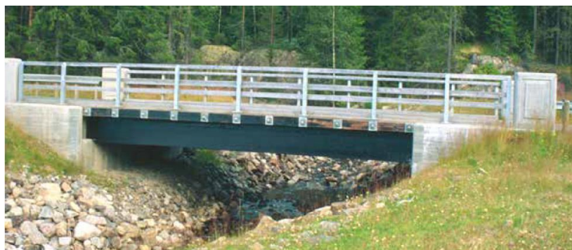
Figur 6-7. Eksempel på treplatebru på stålbjelker, hentet fra Rapport 422 Trebruer. Kilde: SVV.
