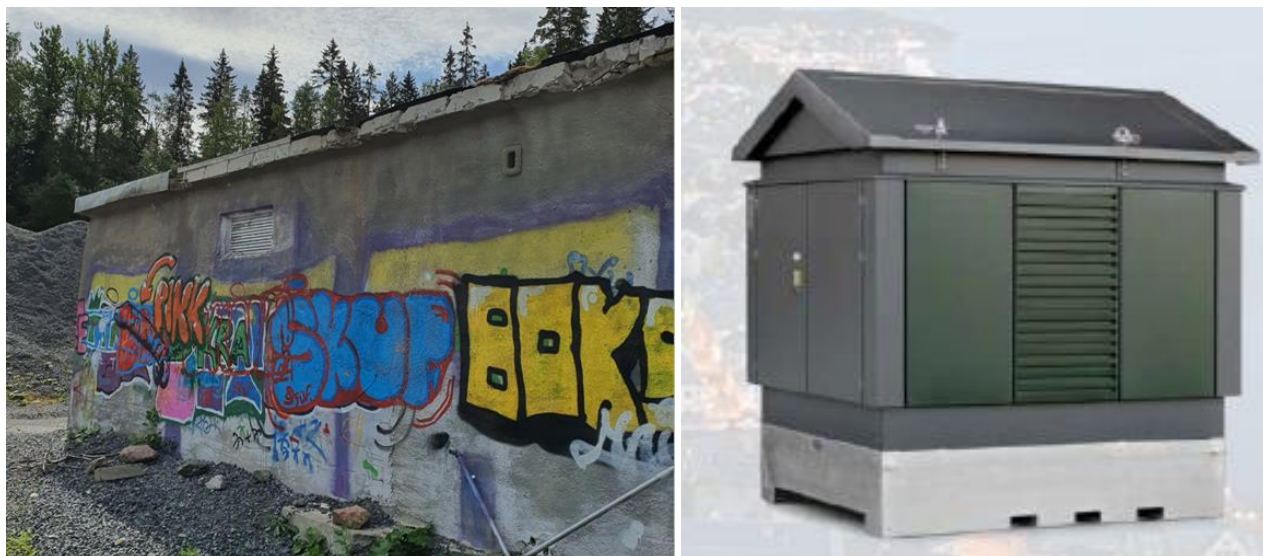
Figur 7-4. Eksisterende nettstasjon i bildet til venstre. Illustrasjonsfoto prefabrikkert nettstasjon til høyre. Kilde: bildet til venstre: Multiconsult, illustrasjonsfoto: møretrafo.no.
