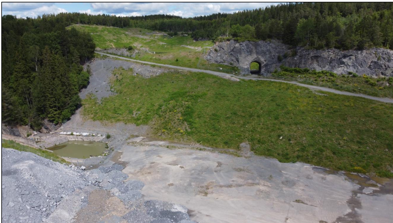
Figur 2-2. Bilde tatt på befaring 13.06.2022 ifm. mulighetsstudiet. Rensedammen i sørbruddet ses på venstre side mens nordbruddet ligger grønt innover i bildet. Kilde: Multiconsult.
