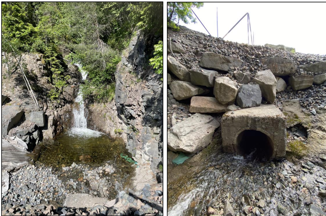
Figur 3-8. Innløp til eksisterende bekk (til høyre). Diameter på innløpet er DN1000. Det er forventet varierende diameter langs bekkeløpet. Oppstrøms er en «foss» med varierende vannføring (til venstre). Kilde: Multiconsult, befarings 13.06.2022
