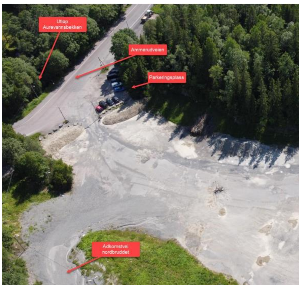
Figur 3-1. Dronebilde fra befaring 30.06.2022. Ammerudveien, parkeringsplassen, adkomstveien til nordbruddet og utløpet til Aurevannsbekken er markert. Kilde: Multiconsult.
