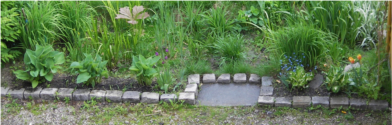
Figur 7. Slamfelle til et regnbed på en privat eiendom. Vann fra gårds plass passerer en skiferplate med storgatestein med spalter. Sjøppel blir liggende på plata.
