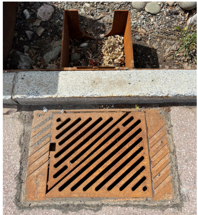
Figur 4. En gaterist i gata kan sluke mye vann, og sykler kan passere trygt når kantsteinen er lav. Trolig ville slisser i kantsteinen i tillegg gitt et forbedret inntak. Rister kan tettes av søppel. Med en velfungerende slamfelle i regnbedets innløp, er ei rist foran åpningen i kantsteinen unødvendig.
