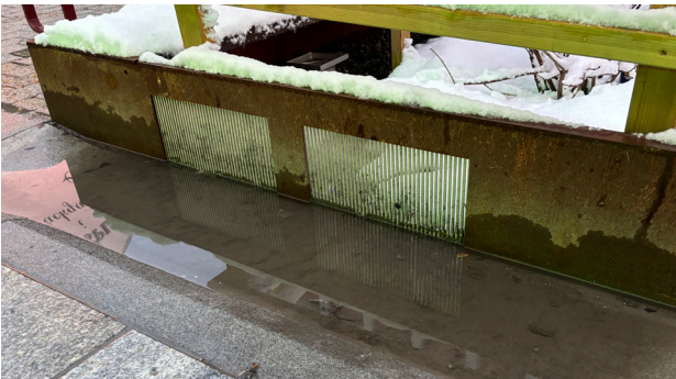
Figur 2. Lokalt nedsenket renne før innløp til et regnbed i ei gågate kan bedre innstrømmingen til anlegget.. Nedsenkningen er tett på muren rundt regnbedet, slik at mulige sykkelister ikke vil sykle i renna. Den langsgående skråkanten må ikke være for bratt slik at folk kan skli når det er vått/glatt. Smale åpninger og noe rusk i rista til regnbedet hindrer vannet fra å strømme inn.
