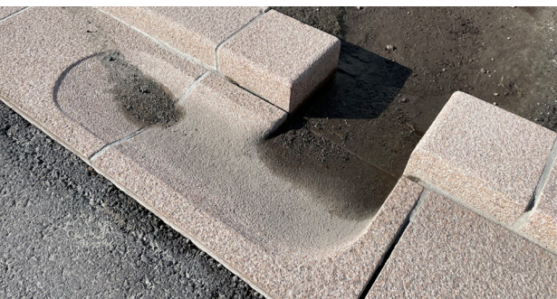
Figur 3. Nedsenket renne før 90 graders venstresving for vannet inn til et regnbed. En dyp nedsenkning vil trolig lede en god del vann til regnbedet (regnbedet mangler for øvrig slamfelle og ekstra volum for overvannet). Denne type nedsenkinger kan imidlertid være farlig for sykkelister, spesielt i nedoverbakker. Et avbøtende tiltak kan være å ha en annen farge på de nedsenkede steinene, slik at de skiller seg ut, eller unngå å legge de i sykkelfelt.
