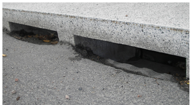
Figur 3. Nedsenket renne før 90 graders venstresving for vannet inn til et regnbed. En dyp nedsenkning vil trolig lede en god del vann til regnbedet (regnbedet mangler for øvrig slamfelle og ekstra volum for overvannet). Denne type nedsenkinger kan imidlertid være farlig for sykkelister, spesielt i nedoverbakker. Et avbøtende tiltak kan være å ha en annen farge på de nedsenkede steinene, slik at de skiller seg ut, eller unngå å legge de i sykkelfelt.
