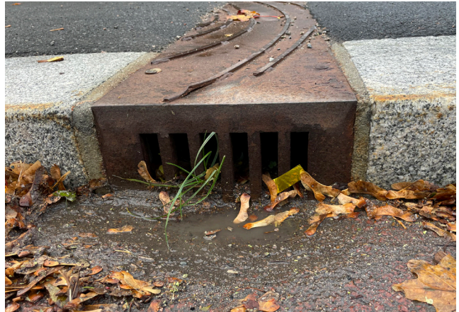
Figur 1. Innløpsrista i fortauskanten var i utgangspunktet tilstoppet av sand etter gatefeing og annet rusk som følger gatevannet (høyre bilde). Selv etter rensing måtte en midlertidig barriere settes opp for å lede vann til anlegget under et forsøk for å teste kapasiteten på regnbedet.
