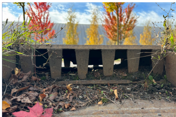
Figur 6. Kjeftesluk med brede glipper mellom tennene, slipper mye vann inn, men kan være vanskelig å rengjøre for sediment ol. som samler seg. Erfaringer viser at «vårrengjøring» med spylebil ikke er tilstrekkelig for å holde kjeftesluk med tenner tilstrekkelig åpne. Manuell rensing må til, men er tidkrevende.
