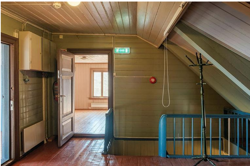
Trapperom i loftetasje - Foto: Nikolai Kobets Freund / Oslo kommune
