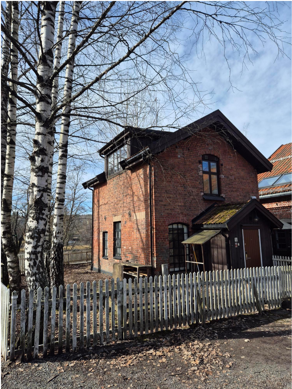
Kjelsåsveien 145 Bilder av uteområdet Foto: Cecilie Nergård © Kulturetaten, Oslo kommune
