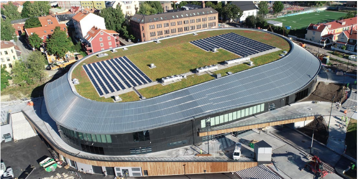
Biosolare tak. Jordal Amfi. Foto: NCC
