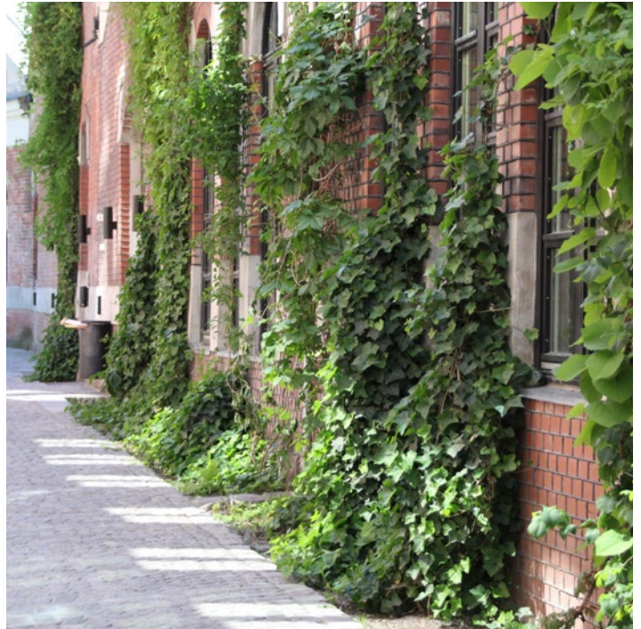
Grønn vegg med klatreplanter. Vegg med spredte klatreplanter som vokser fra jordbed i bakken. Nedre gate 7, Oslo. Foto: Plan- og bygningsetaten.
