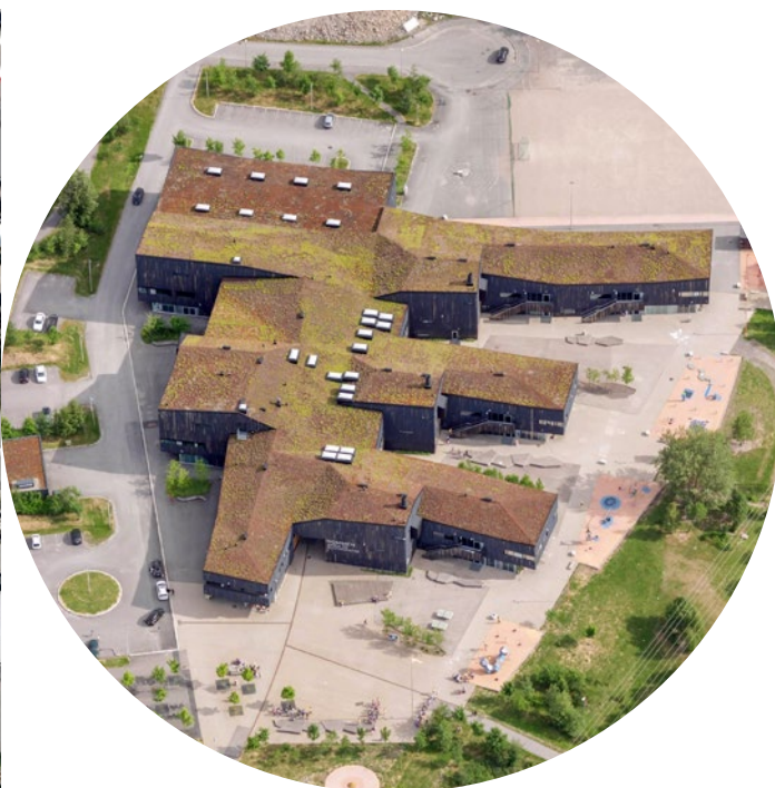
Vegetasjonstak. Rommen skole. Foto: Blom
