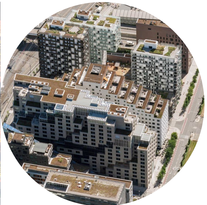
Grønn takterrasse. Barcode. Foto: Blom
