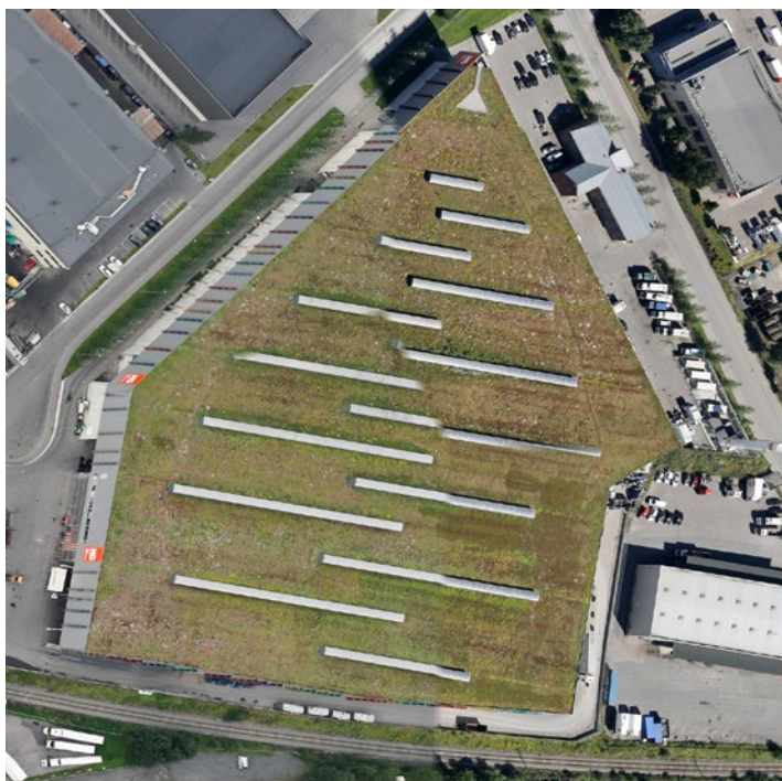
Vegetasjonstak. Gjenvinningsanlegget til Veolia Miljø. Foto: Blom
