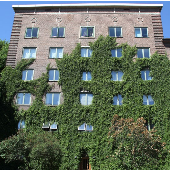
Grønn vegg med klatreplanter. Tradisjonell grønn fasade i Oslo. Waldemar Thranes gate 62-64, Oslo. Foto: Plan- og bygningsetaten.
