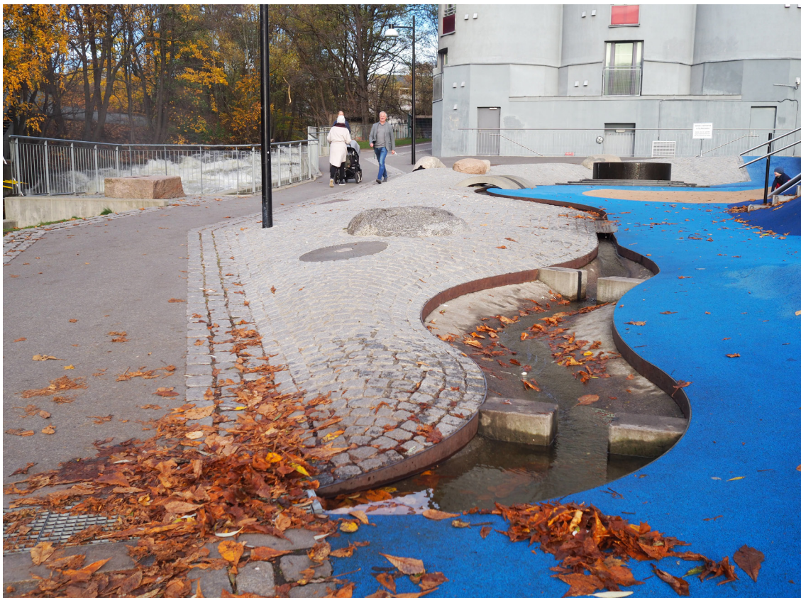
Vannlek integrert i overgangen mellom gangvei og lekeplass på Nedre Foss, som eksempel på hvordan det kan gjøres i overgang mellom lekeplass og plaskedam.
