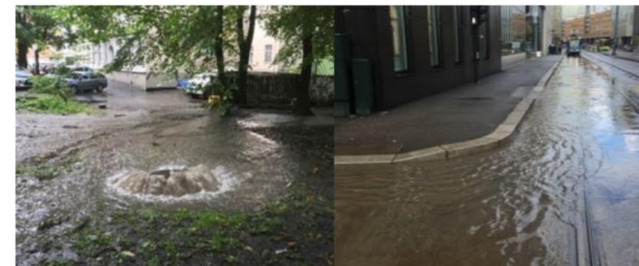
Figur 3-23: Vann strømmer opp fra kumløkk (venstre) og oversvømmelse i Schweigaards gate. Bildene er fra 2017 (foto: VAV v/Marit Løberg)
