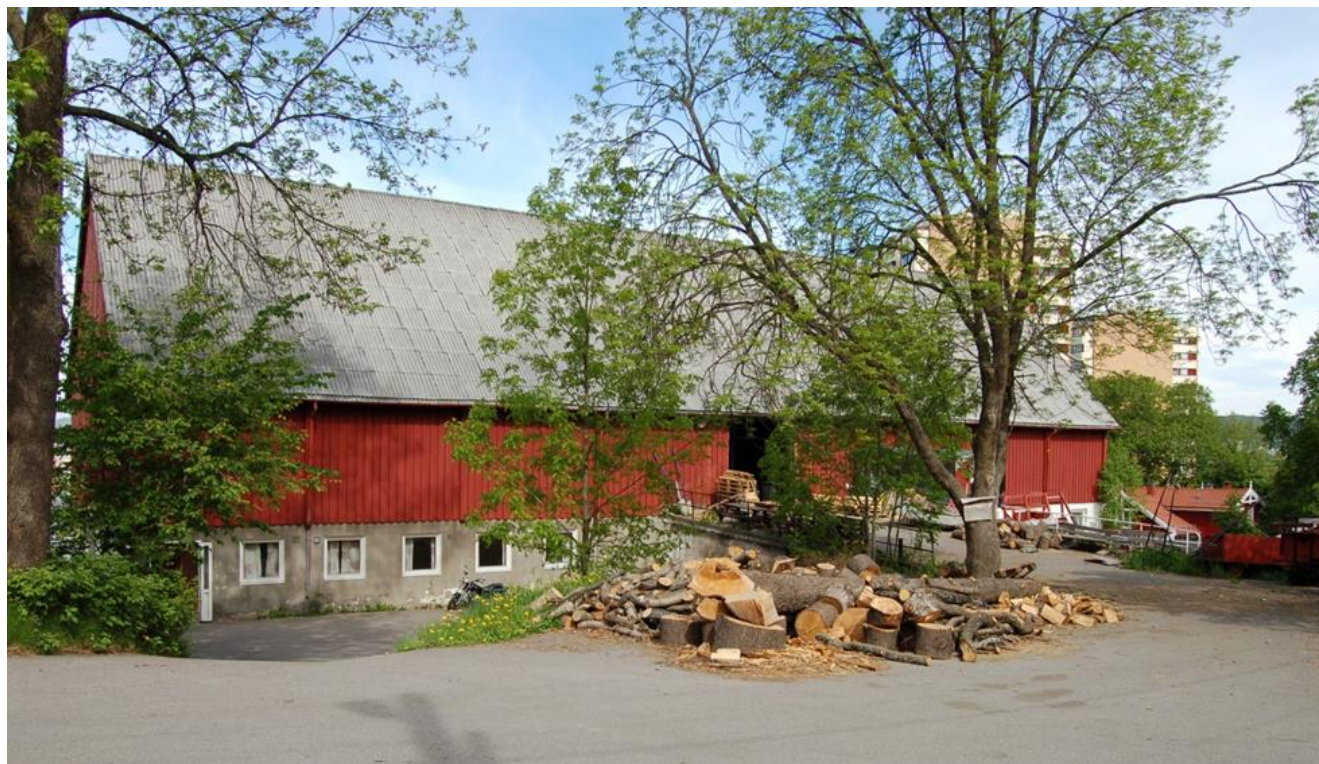
Driftsbygningen på Nordre Trosterud gård, var den siste bygningen som ble oppført i regi av asylet.
