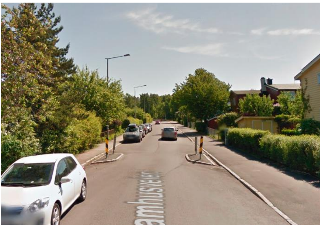
Bilde 2: Innsnevring til ett felt, Ekeberg (Foto: Google)
