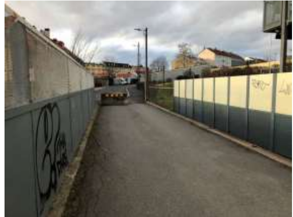
Figur 9: Bro over Gjøvikbanen sett mot Etterstadgata
