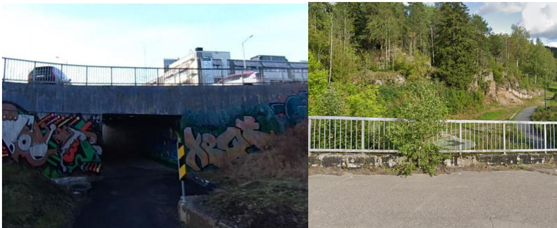
Bilde 4: Identifisert flaskehals ved undergang for g/s-veg mellom Byparken og Skullerud Idrettsanlegg.
