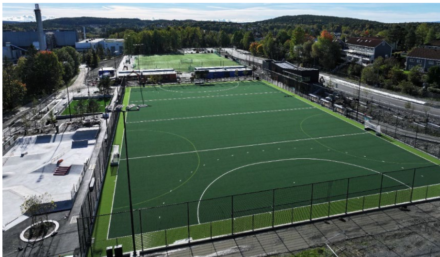
Den nye landhockeybanen på Mortensrud ble ferdigstilt høsten 2024.
