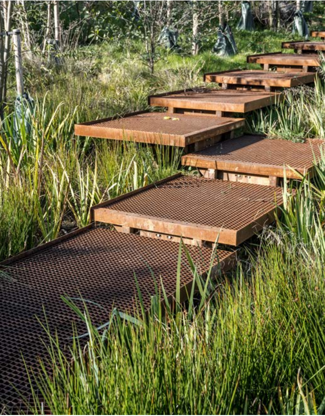
Remiseparken i København rommer god plass for overvannshåndtering. Over de våte områdene er det lagt til rette for å gå over på små, perforerte broer og ramper. Foto: Coast Studio
