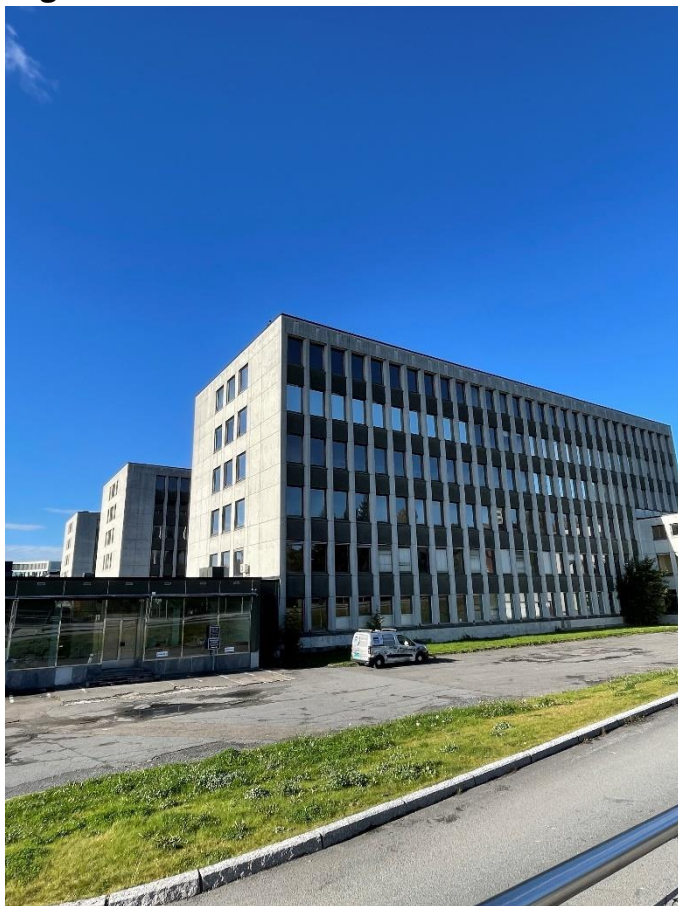
Note: Sogn videregående skole fotografert i forbindelse med Kommunerevisjonens observasjon 3. oktober 2022. Foto: Kommunerevisjonen.
