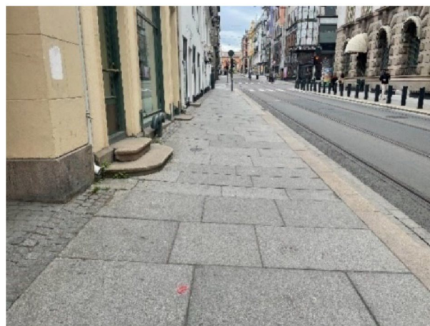
Figur 12 Fortau med trapper
