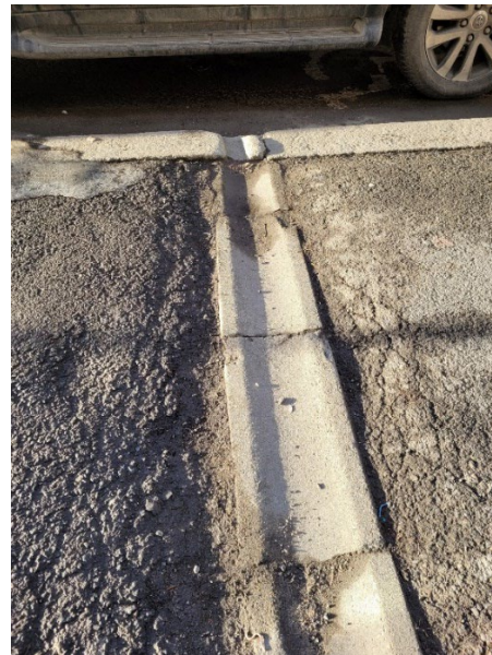
Figur 7 Vannrenne på tvers av fortauet langs HC-parkeringsplass i Nedre Slottsgate
