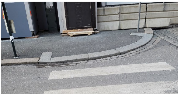
Figur 32 Nedsenk fra gangfelt i krysset mellom Otto Sverdrups gate og Hieronymus Heyerdahls gate
