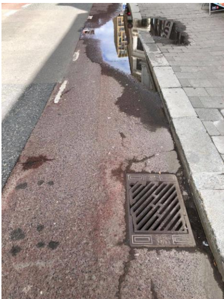
Foto 11: Vanndam ved Skippergata 32. Bildet er tatt 27. mai 2021.
