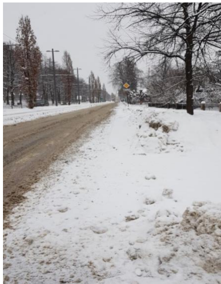
Bilde 3 Ikke bar asfalt, Kirkeveien 06.02.2019
