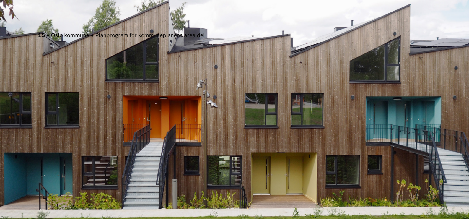
Førstehjemsboliger i Ulsholtsveien 31 på Furuset. Prosjektet er et forbildeprosjekt i FutureBuilt og er utviklet av stiftelsen Betanien med Haugen/Zohar arkitekter og Dronninga landskap AS. Foto: Plan- og bygningsetaten
