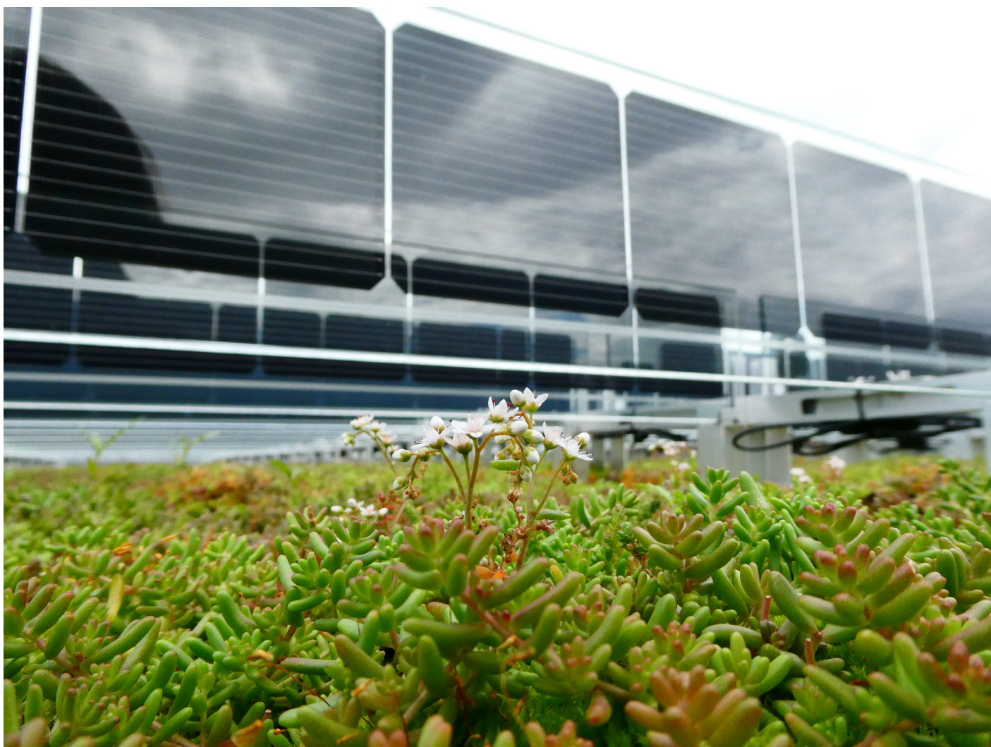
Sedum og solceller på Løren skoles tak.
