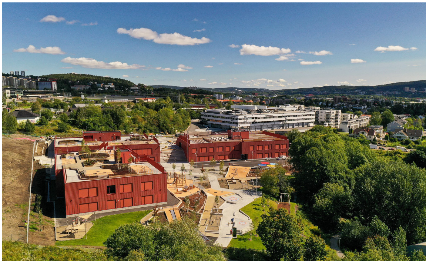
Refstad skoles tre bygg med grønne tak.
