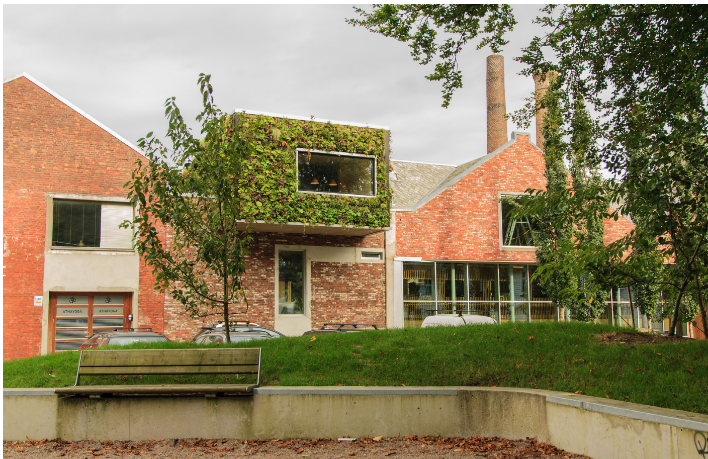
Mellombygget med den grønne fasaden erstattet et lager mellom to andre bygniger.
