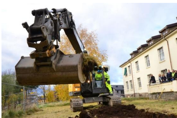
Første spadetak Ullerntunet, totalentreprenør Reinertsen AS
