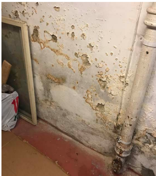
Fukten har over lengre tid trengt inn i kjeller. Foto: Lala Tøyen
