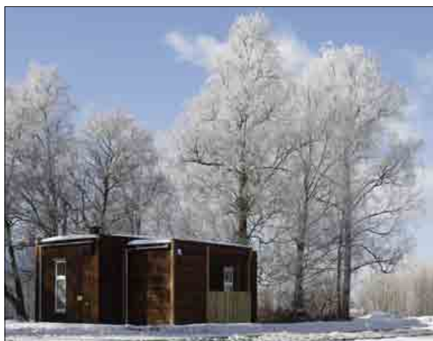
Modulhus i Strømsveien 186. Målet er å få satt opp 20-30 hus i 2013 for målgrupper med dårlig boevne. Modulene er tilpasset hard bruk, de er fleksible og kan plasseres slik at man får utnyttet tomten bedre. Husene kan tilpasses arkitektonisk inn i nærmiljøet Foto: Terje Heiestad
