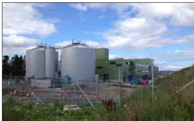
Biogassanlegget i Nes ble bygget ferdig i desember 2012 Foto: Energigjenvinningsetaten
