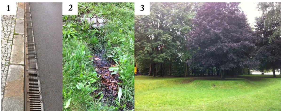
Bilde2.1: Sluk på gateplan (kant på vei) som fanger opp regnvann. 2: Veivannet renner ut i parken. 3: Vannet når tilslutt et fordrøyningsbasseng med stor kapasitet. Overvannet renses ved hjelp av grøntområdet .
