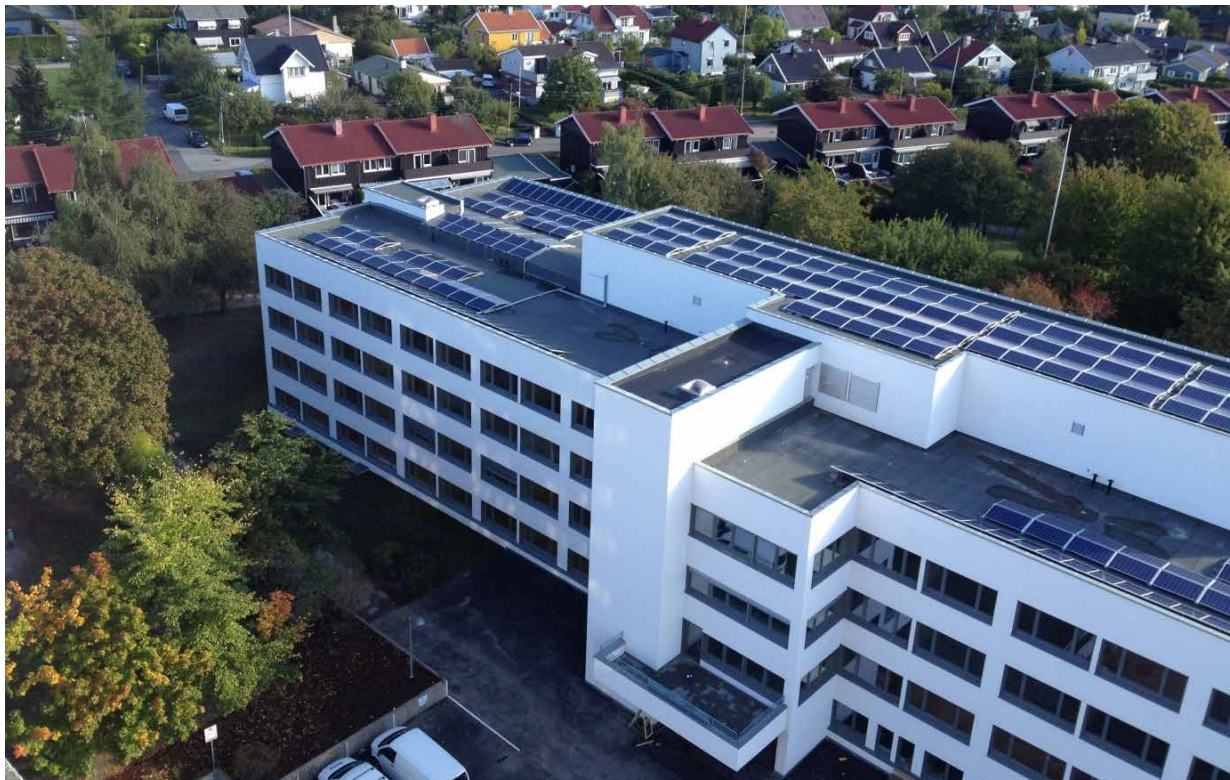
Økern sykehus er blitt rehabilitert med mål om å kutte energibruken i bygget med nærmere 70 prosent. I tillegg skal minst 10 prosent av energiforbruket dekkes av produksjon fra solcellepaneler. Økern sykehus er et eksempel på et Future Built-prosjekt. Foto: Tove Lauluten
