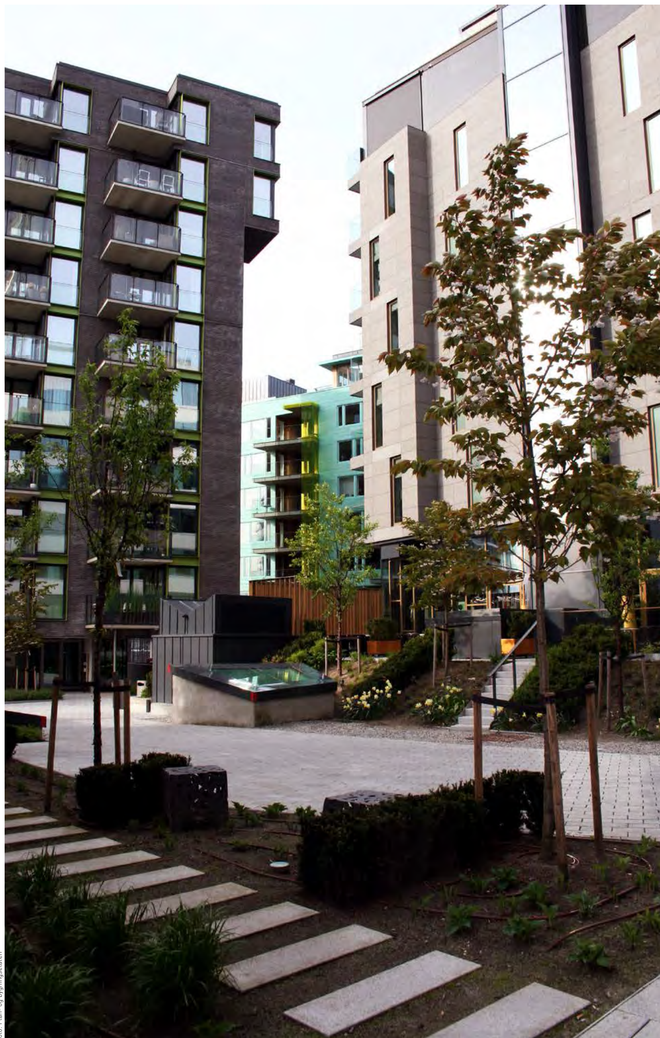
Foto: Plan- og bygningssetaten
