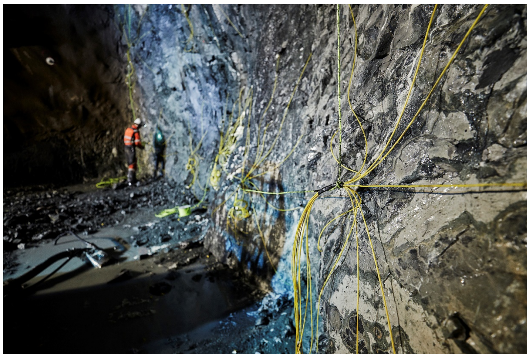
Figur 4 Kobling av sprengladning med nonel tennsystem. Foto: Veidekke
