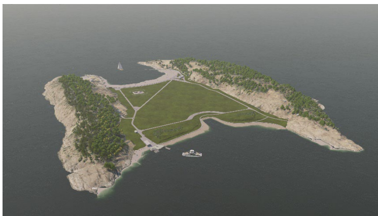
Langøyene – slik skal det bli når arbeidene er ferdig
