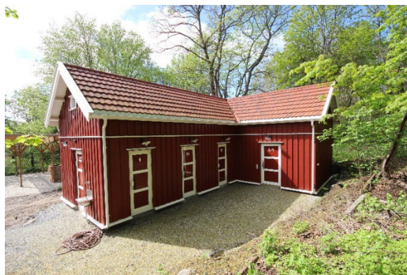
Utedoene ved Gressholmen kro er erstattet med et nytt uu-tilpasset toalettbygg.
