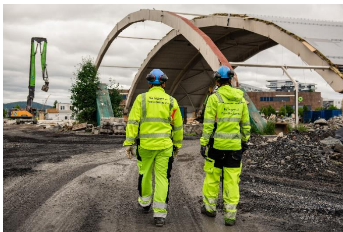
Det har foregått omfattende grunnarbeider på anleggsområdet for Fornebu stasjon og base i 2021. Foto: Nicolas Tournenc
