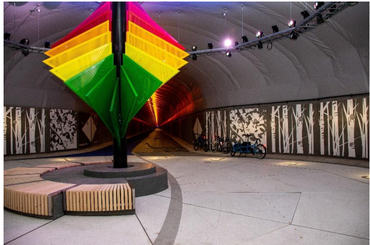
Fyllingsdalstunnelen i Bergen. Foto: Asle Bentzen/Bergen kommune
