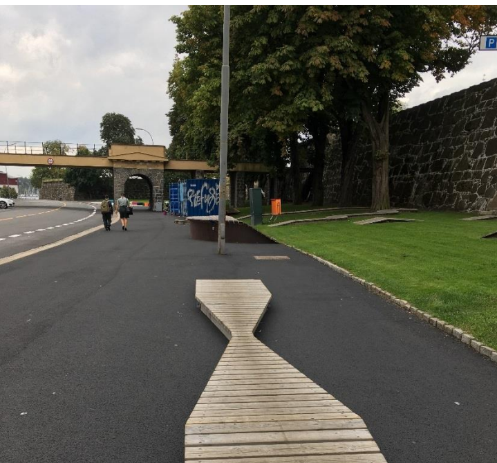
Før tiltaket, juni 2017
