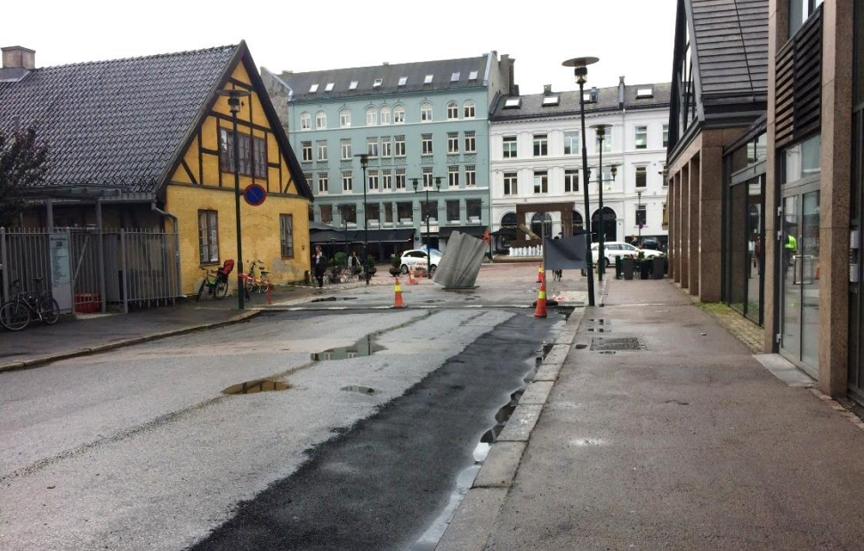
Før tiltaket, juni 2017
