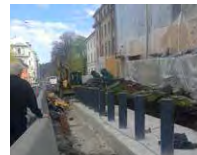
Permanent sikring ved Myntgata .
