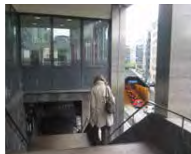
Fotgjengerbro- og tunnel. Ring 1.
