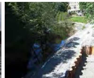
Midlertidig anleggsarbeid langs Akerselva i 2013.
