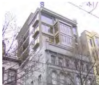
Fortetning i høyden er lite synlig fra gaten og skaper flere boliger. Melbourne, Australia.
