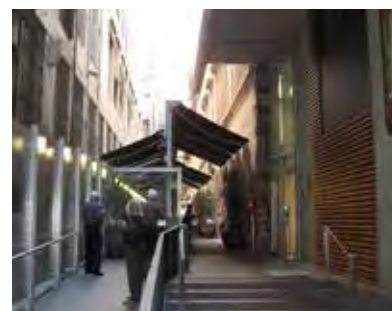
Ramper sammen med trapper gir adgang for alle. Bourke street Mall, Melbourne, Australia.
