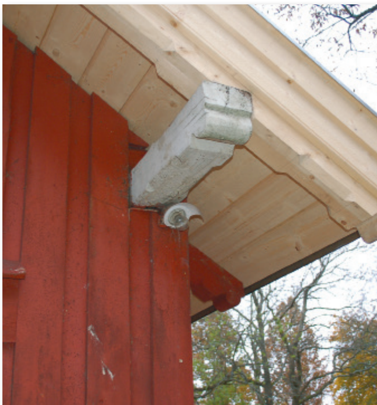
Reparasjon av råteskadet tak og gjenbruk av gammel takstein
