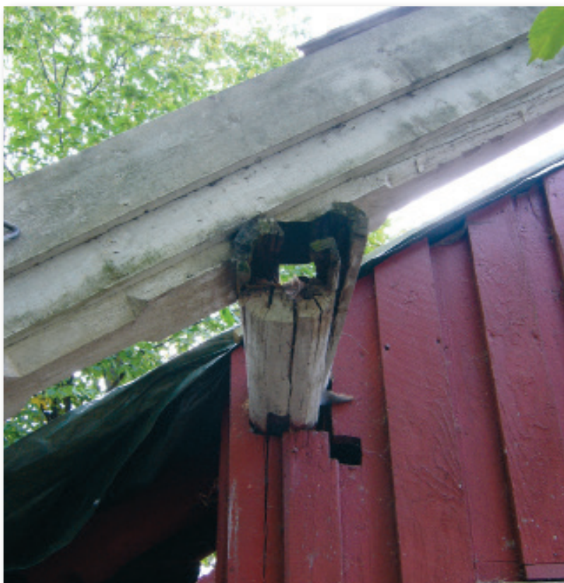
Trondheimsveien 319, uthus på Linderud gård
