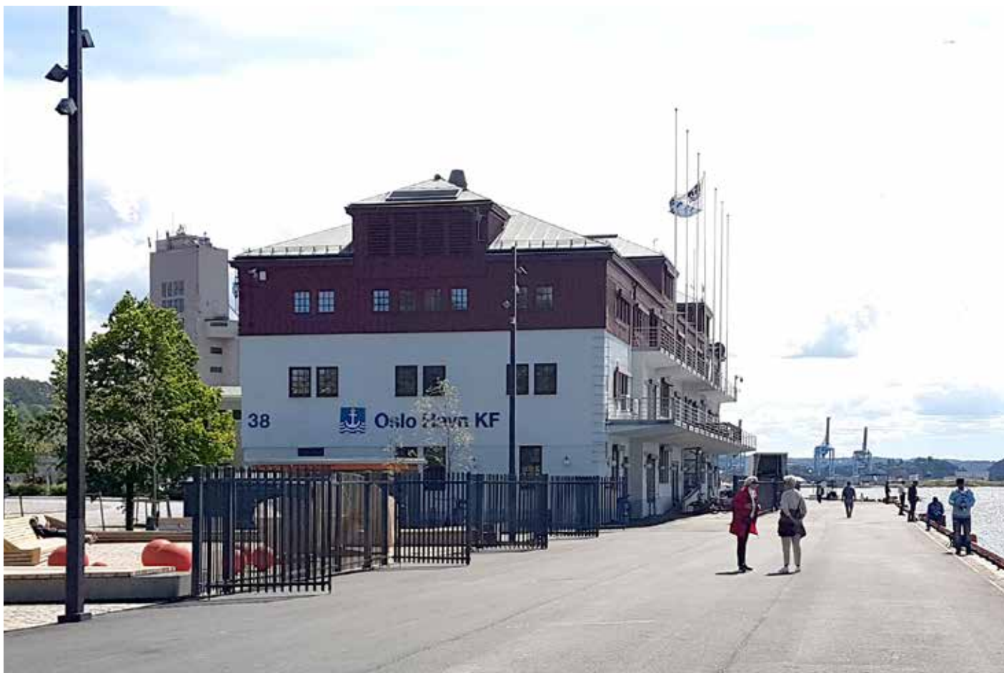
Amerikalinjens første terminalbygg ligger på Akershusstranda, omtalt som skur 38. Bygningen representerer både den første direkte linjefarten til Amerika samtidig som den forteller en viktig del av utvandringshistorien i Norge. Foto: Plan- og bygningsetaten
