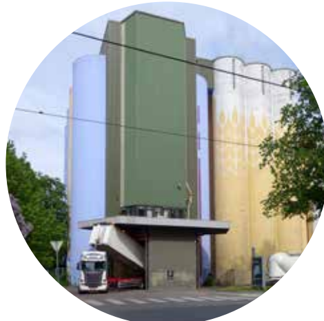
Bjølens valsemølle på Sandaker fra slutten av 1800-tallet er fortsatt i full drift, og formidler vannkraft og næringsvirksomhet langs byens elveløp. Foto: Plan- og bygningsetaten
