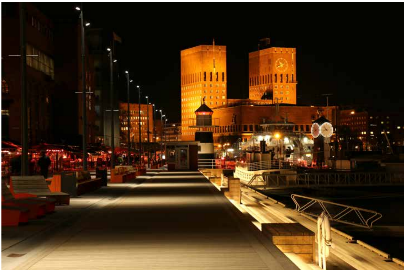
Aker brygge med fjordpromenaden og Rådhuset i Pipervika i kveldslys. Foto: Plan- og bygningsetaten
