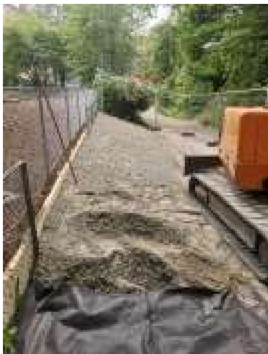
Figur 26: En større del av barnehagens uteoppholdsareal ble som strakstiltak dekket med fiberduk, rene masser og topplag av bark, for fortsatt å fungere som lekeareal.
