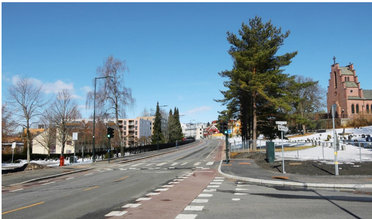
Figur 3.4-1 Planområdet og Nordstrand kirke sett fra Ekebergveien
