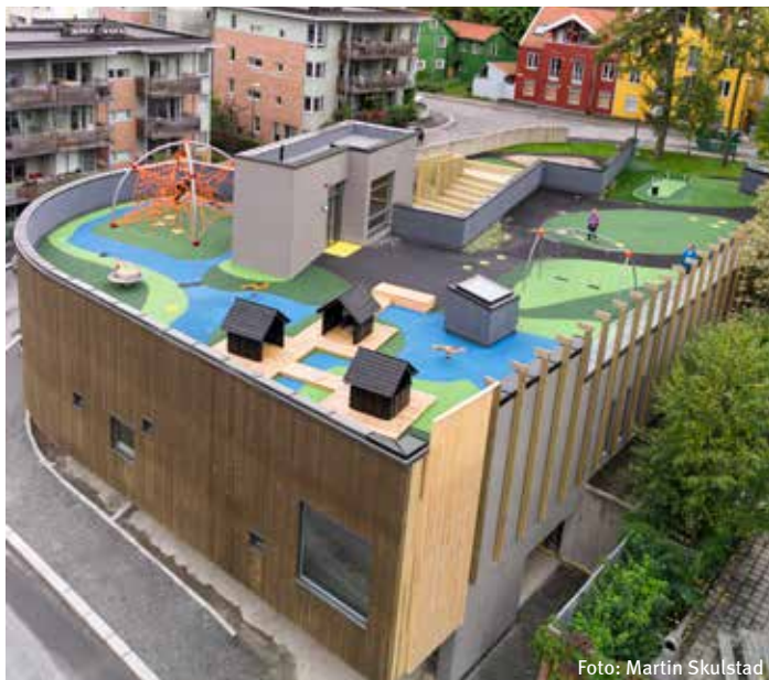
Eksempel på barnehage: Baglerbyen barnehage i Konows gate 20 i Gamlebyen, Oslo. Innpasset i en tett bysituasjon med karakteristiske trefasader og leke- og uteoppholdsarealer på tak, fordi bygget fyller hele tomten på bakkeplanet i skrånende terreng. Forslagsstiller: Veidekke Bolig AS. Arkitekt: Linje Arkitektur AS.
