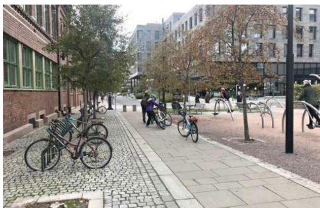
Rundt hjørnet av bygningen til venstre ser vi en ny, bymessig opparbeidet gate som går gjennom Skøyenområdet nord-sør og forbinder Thune med Sjølyst. Design og innredningsbutikken Expo Nova til høyre i bildet utfyller Thune-området som et stort verksteds- og designcluster. (Foto: Kjell Kr. Jacobsen, PBE)
