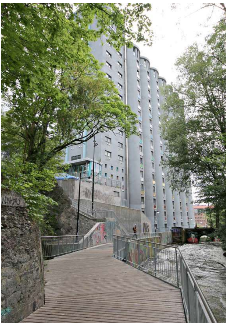
Grünerløkka studenthus (populært kalt «Studentsiloen») ved Nedre Foss, på østsiden av Akerselva. God gjenbruk av bygningsmassen i den tidligere kornsiloen fra 1953, bygget i tilknytning til virksomheten ved Nedre Foss mølle. Siloen ble ombygd i 2001 til mer enn 200 studenthybler og leiligheter for Studentsamskipnaden i Oslo og Akershus. Bygningens karakteristiske fasade har 3 rekker med 7 silosjakter, og er ikke vesentlig endret etter ombyggingen. Nedre Foss bypark med amfi i forgrunnen. (Foto: PBE)
