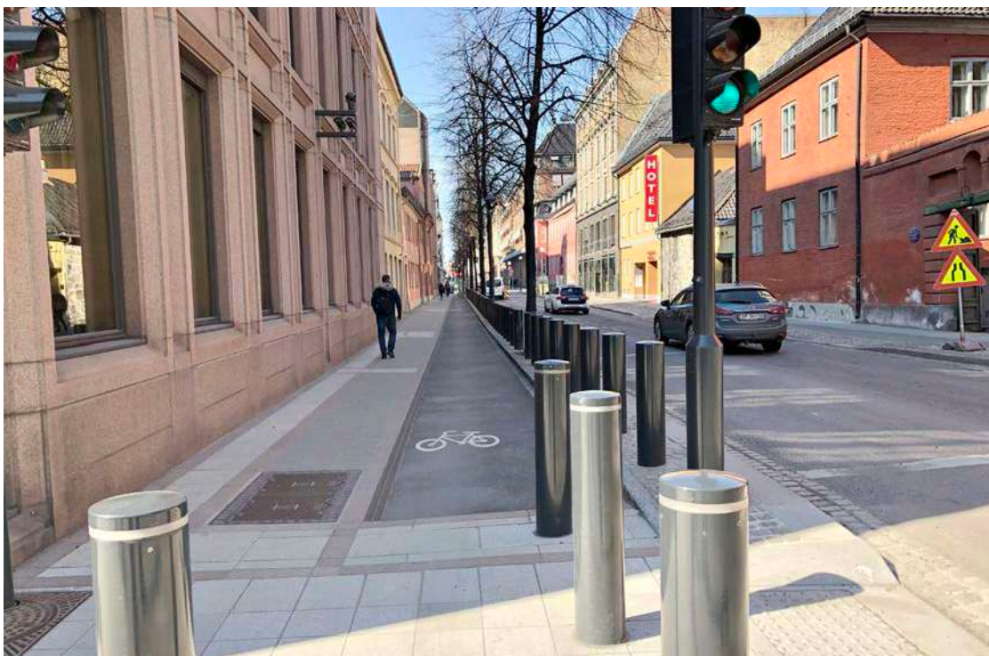
Prioritering av fotgjengere i Rådhusgata. Her er gatetversnittet såpass trangt at sykkelfeltene på hver side av tofelts kjørebane må klare seg med minst mulig bredde, for å kunne prioritere størst mulig fortaubredde for fotgjengere. Samtidig gir gaten også plass til tre-rekker i steinsatte rabatter på hver side av kjørebanen. Fremtidig løsning kan være å gjøre fortau og sykkelfelt om til bredt fortau og gjøre gaten enveiskjørt med separat sykkelfelt i øst-vestlig retning og sykling i blandet trafikk i vest-østlig retning. (Foto: Kjell Kr. Jacobsen, PBE)
