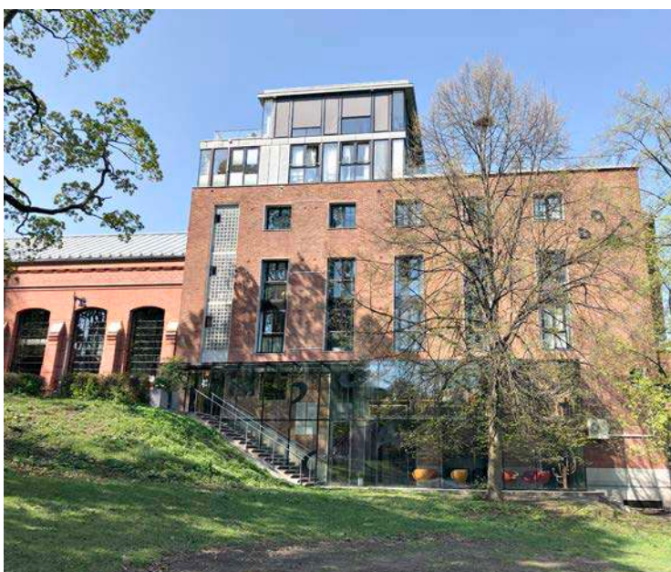
Hausmannsgate 16: Godt eksempel på vellykket endring og ny bruk av bevaringsverdige enkeltbygg. Bebyggelsen ble regulert i 2002 til bl.a. kombinerte formål med bolig, kontor, forretning, bevertning og allmennyttig formål (undervisning, kultur), og huser i dag bl.a. stiftelsen «Design og arkitektur Norge» (DOGA). Reguleringsplanen fastla at rehabilitering og ombygging skal utføres på en slik måte at anleggets kvaliteter bevares. Bevaringsverdiene og tidsdybden er her videreført på en god måte. (Foto: Kjell Kr. Jacobsen, PBE)
