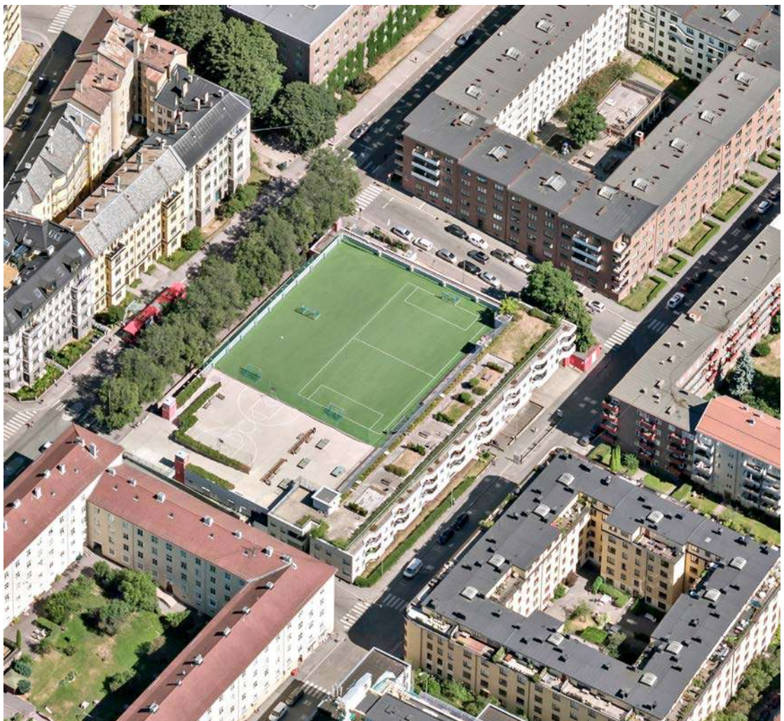
Over: I den tette byen er arealknapphet en økende utfordring. Det kan likevel gi merverdi til byen når den håndteres på en god måte. På Falck Ytters plass ble det i 2005 etablert fotballbane på taket av et flerfunksjonelt bygg som huser både bolig, næring og et lite kjøpesenter. (Foto: Oslo kommune)
