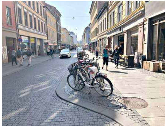
Torggata: Enveiskjørt sykkelgate med redusert biltrafikk og prioritering av gående og syklende. Materialmessig god utforming med sykkelparkering, oppholdssoner og vareleveringslommer. (Foto: Kjell Kr. Jacobsen, PBE)
