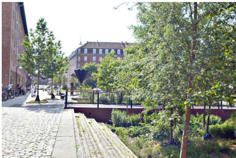
Overvannsløsninger: Fordrøyningsbasseng med frodig vegetasjon, sitemuligheter på benk eller i amfi, og bruk av naturstein i ulike formater. Tåsinge plads København. (Foto: Mari Haraldsen, PBE)
