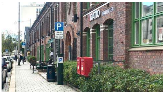
Tradisjonsrike Thune mekaniske verksted er i dag utviklet til et karakteristisk og flerfunksjonelt byområde/kvartal, hvor den eldre industribebyggelsen er bevart med vakre fasadedetaljer i teglstein. (Foto: Kjell Kr. Jacobsen, PBE)
