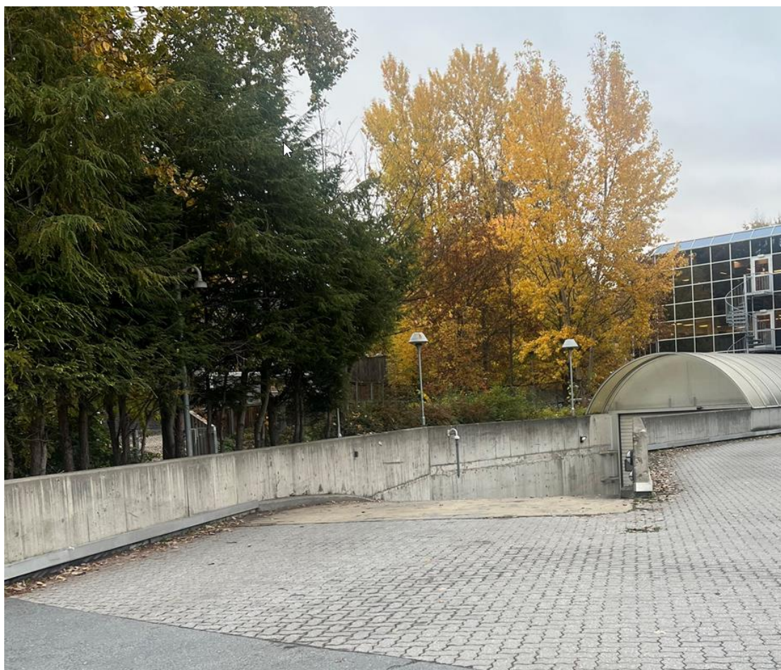
Figur 4-6: Nedkjøring Oksenøyveien 3 tatt 17.10.24. Området vil ikke bli berørt ved bygging av ny stasjonsadkomst A
