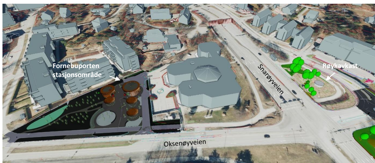
Figur 1-1: Fornebuporten stasjonsområde og røykavkast på andre siden av Snarøyveien
