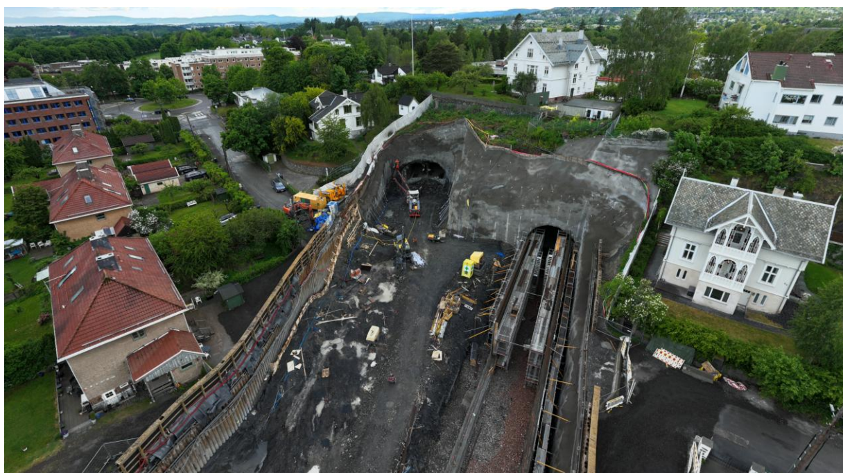
Bildet viser status per 26.5.2025. Ny inngående trasé til venstre, ny utgående trasé Fornebubane til høyre.
