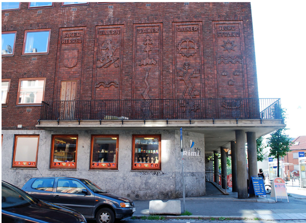
Trondheimsveien 5, tidligere Aker herredshus (1939–41), nylig ombygget til boliger med forretninger i 1. etasje. Fasaden har bl.a. innmurte relieffer med motiver som symboliserer de fire Akersognene. Den nye virksomheten har fått en skilting som langt på vei respekterer bygningens særpreg.
