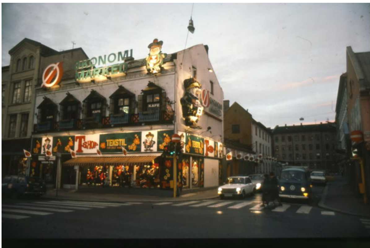
Grønland 18. Øverst: 1960-årene, med forretningsfasaden fra ca. 1930. Nederst: Samme fasade på slutten av 1970-tallet. Den gamle forstadsbebyggelsen var på denne tiden mer eller mindre begravd i skilt og reklameelementer (Foto, øverst: Byantikvaren, nederst: R. Thoresen / Oslo byarkiv)
