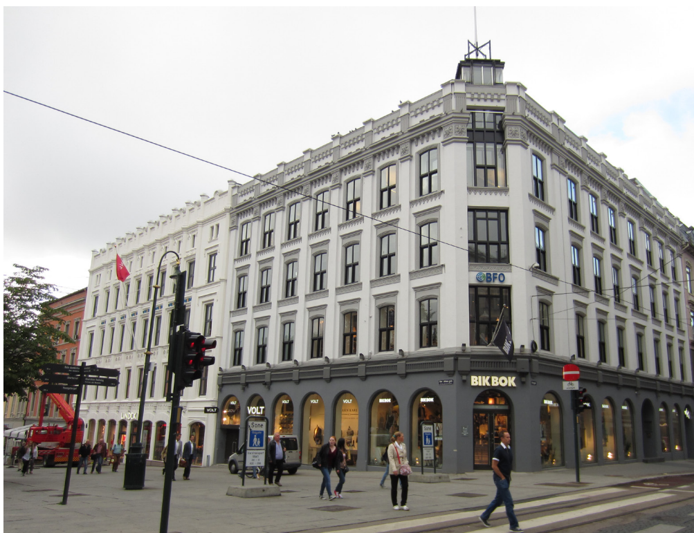
Karl Johans gate. Åpent skilt over hovedinngangen kombinert med lysende bokstaver i bueåpningene gir et ryddig inntrykk, og kommer ikke i konflikt med viktige arkitektoniske detaljer. (Foto: Byantikvaren).
