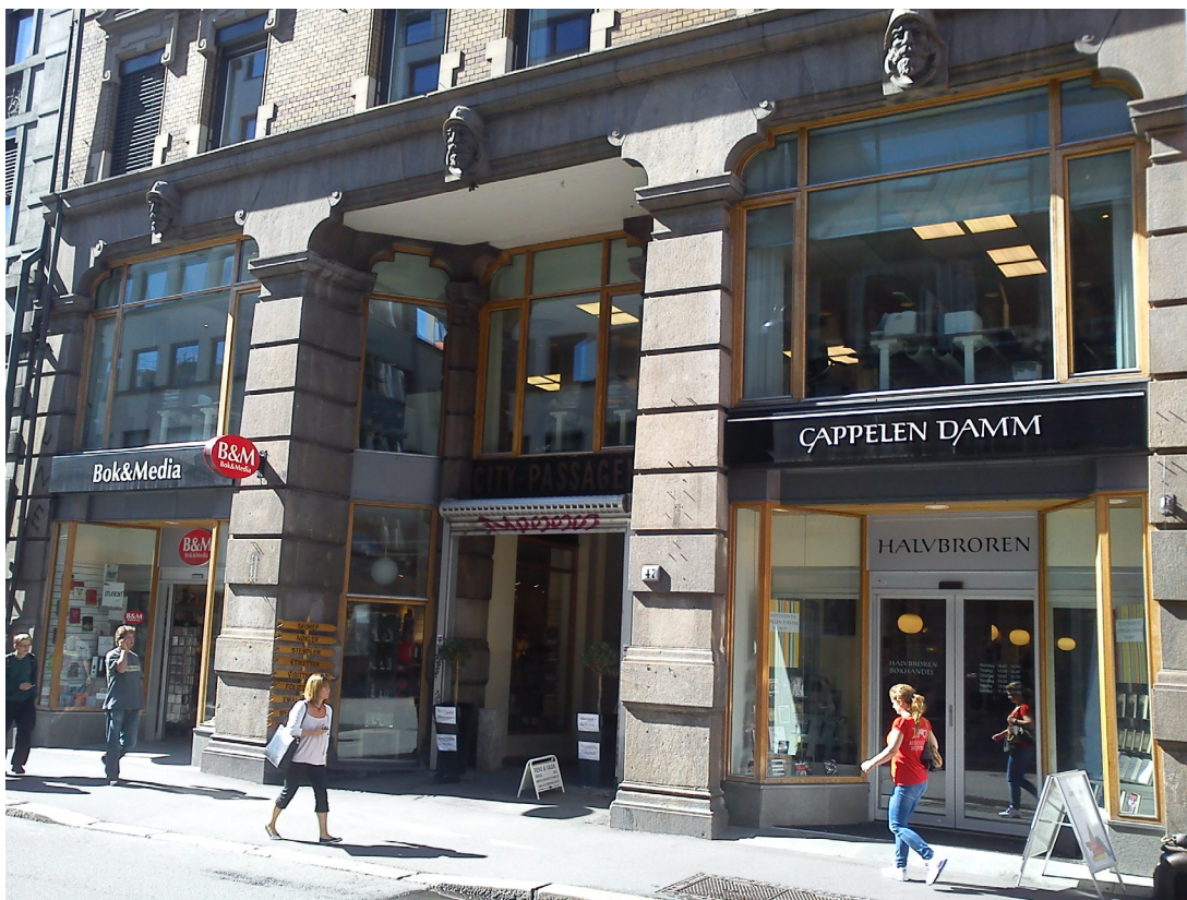
City Passagen – Akersgata 47. De integrerte skiltflatene er videreført. Det røde uthengsskiltet er uheldig montert på pillaren til venstre. Merk også de mange skjemmende sporene etter tidligere skilt på pillaren til høyre. (Foto: Byantikvaren).
