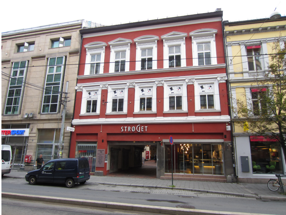
Storgata 13 med "Strøget" – passasjen gjennom gårdsrommet opp til Torggata. Forretningsfasaden har vært ombygget en rekke ganger. Det nåværende åpne skiltet er korrekt plassert på gesimsbåndet. Trolig hadde det vært en enda bedre løsning å ta i bruk de nyere inntrukne skiltflatene under. (Foto: Byantikvaren).
