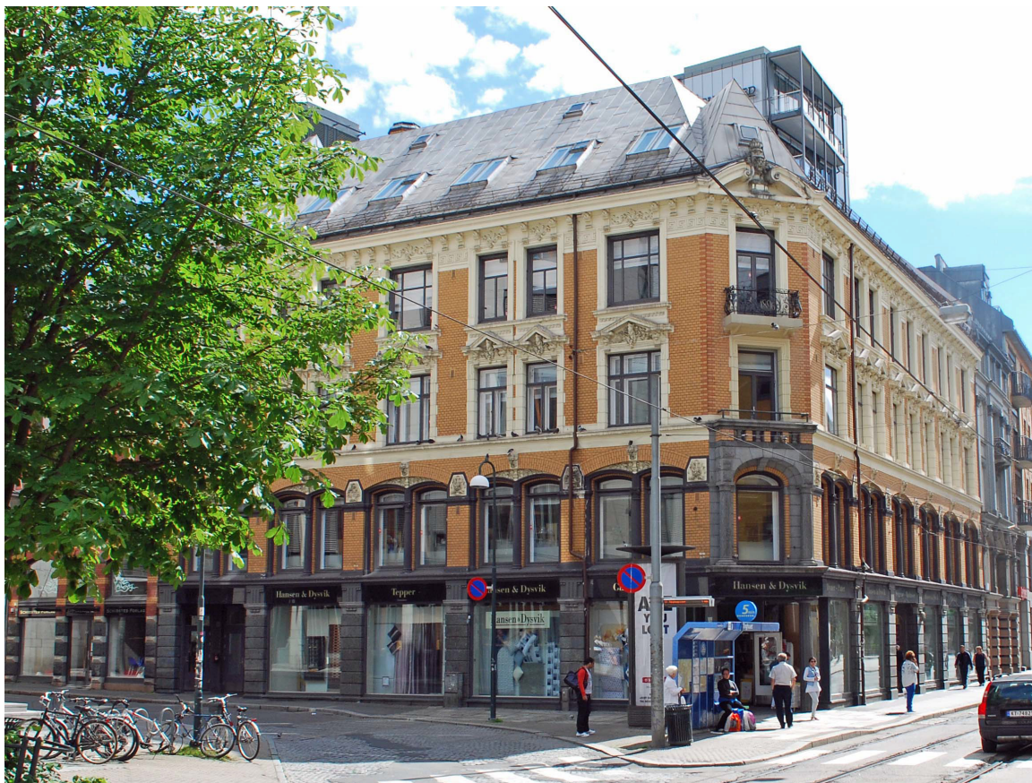
Pilestredet 12. Tilbakeføring til opprinnelig skiltplan med sorte glasskilt og bokstaver i bladgull. (Foto øverst: R. Thoresen / Oslo byarkiv).
