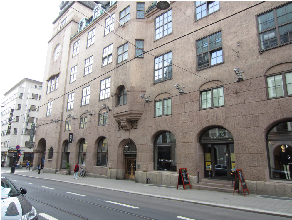
Det tidligere hovedpostkontoret er nå innredet med forretningslokaler på gateplanet. Offentlig monumentalbygning i nybarokk tegnet av arkitekt R. E. Jakobsen og oppført i to faser mellom 1914 og 1924. Både arkitektoniske og kulturhistoriske hensyn legger begrensninger for profilering av de individuelle virksomhetene. Postens gamle hjørneskilt er blitt bevart med ny tekst. (Foto: Byantikvaren).
