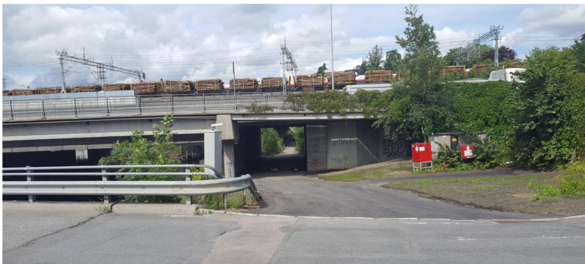
Figur 1-9: Landskapet i planområdet er generelt preget av barrierer: bruer for infrastruktur som E18 og jernbanen. Dette deler Lysakerområdet. Tverrforbindelse for gående er turveg på Oslosiden av elva som går frem til Sollerudstranda via undergangen under E18 eller på fortau langs Strandveien.
