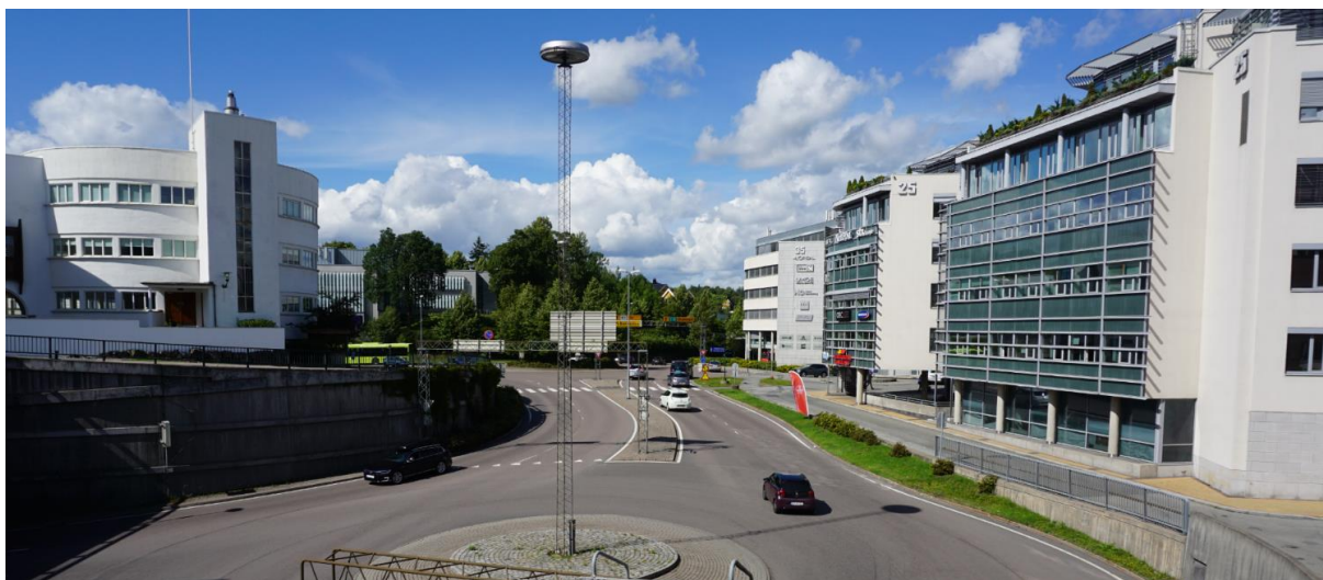
Figur 1-12: Eksempel på dagens lokalvegssystem; Vollsveien på Lysakerlokket.
