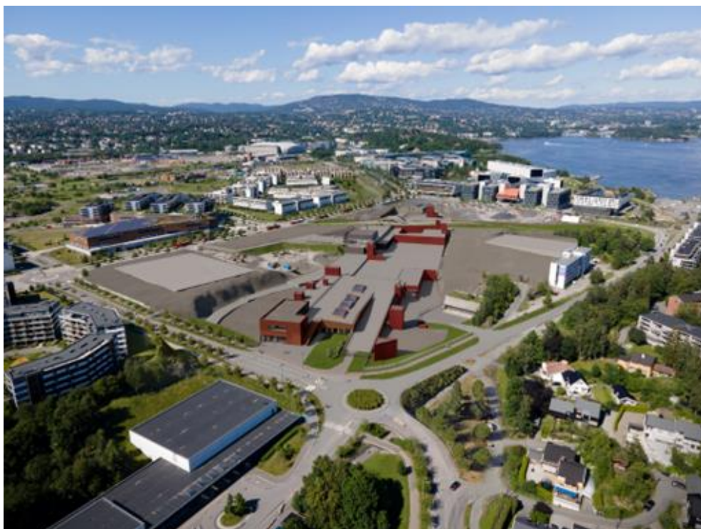
Illustrasjonen viser Fornebu stasjon og base (midt i bildet) slik den blir når arbeidene er ferdigstilt.
