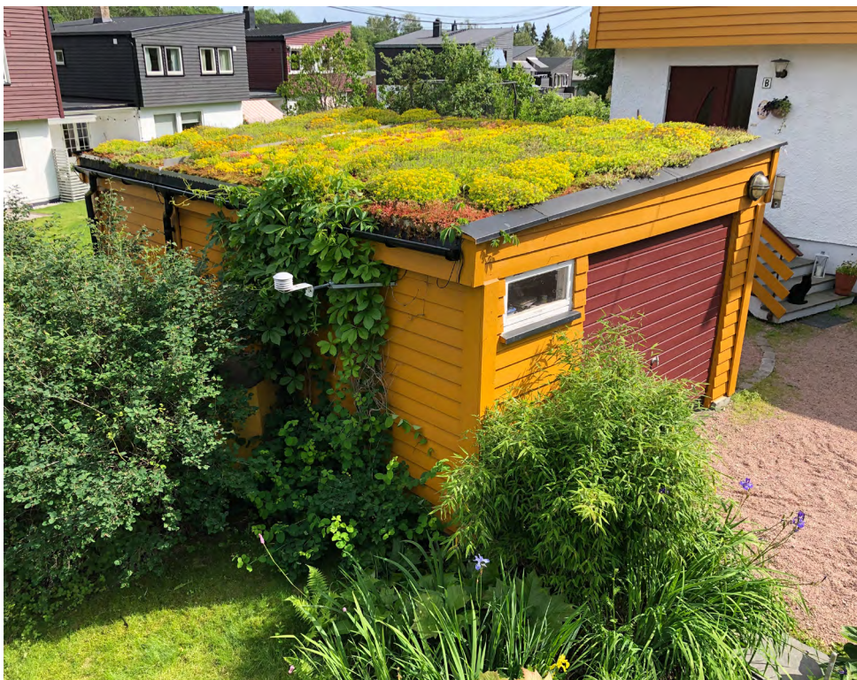
Eksempel på infiltrasjon med grønt garasjetak. (Foto: Bent Braskerud)
