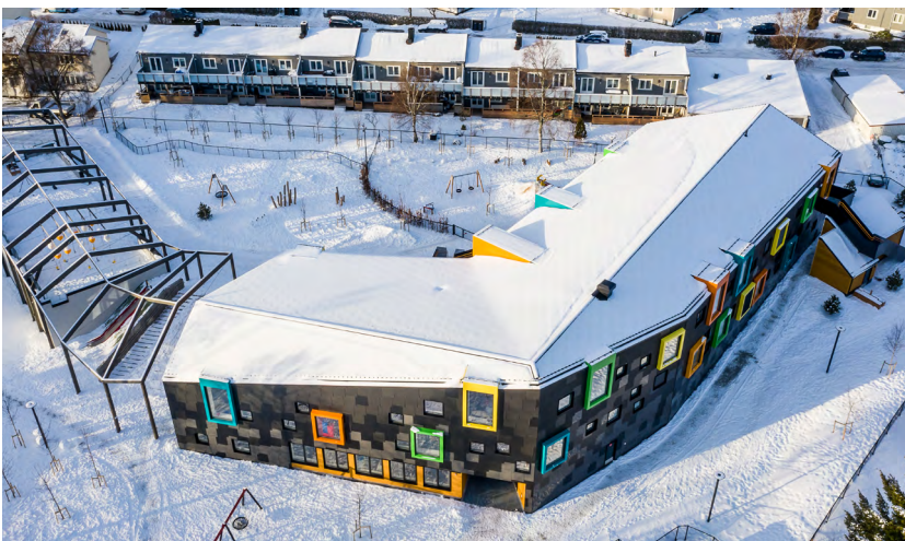
Kilden barnehage. Gjenbrukt aluminium i kledning og gjenbruk av elementer fra eksisterende bygg. (Foto: Tove Lauluten, FutureBuilt)
