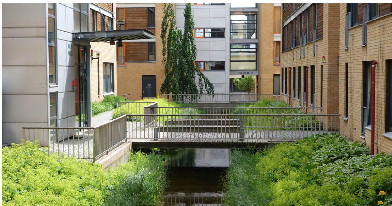
Eksempel på fordøying med åpent magasin og permanent vannspeil i Bjølsen studentby. (Foto: PBE)
