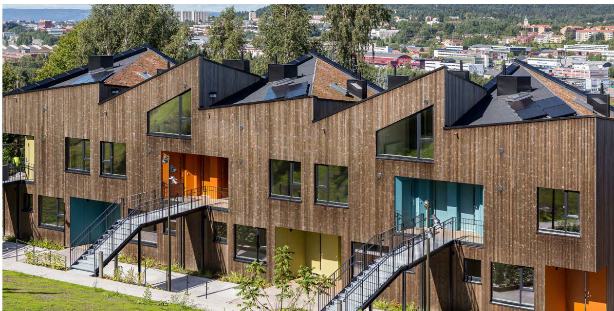
Ulsholtsveien 31. Passivhusstandard med bl.a. solcellepaneler på sørvendte takflater. (Foto: Tove Lauluten, FutureBuilt)
