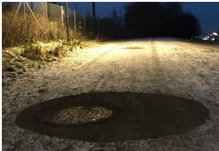
Figur 2: Plasseringen av ledninger kan ikke bedømmes på grunnlag av kart alene. Ledninger er ikke alltid presist stedfestet. Utstyr som kummer er punktmarkert, med utgangspunkt i kumløkkets plassering. Som vist her, så ligger kumløkket sjelden midt i kummen; snøen har smeltet over kummen (Foto: Eyvind Andersen)
