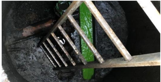
Figur 7: VAV stoler på at ansvarlig søker sikrer at det bygges i samsvar med tillatelsen. Noen ganger foretar likevel VAV kontroller. Her er fargeprøving brukt til å avdekke ulovlig tilkobling av takvann til avløpsledning. Grønn farge er tilsatt taknedløp, og spores i kum nedstrøms (Foto: Kjell Pedersen)
