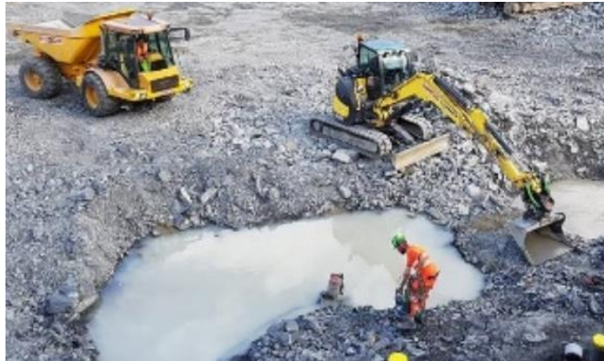
Figur 8: Vann i byggegropen ønskes ofte pumpet til VAVs nett, og det må søkes om dette (Foto: VAV)
