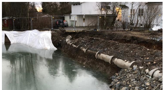
Figur 4: Betongrøret på bildet er en lukket bekk. Grunnvannsnivået i området vil ofte følge den lukkede bekken. Når rørene er fulle, kan flomveien renne på overflaten (Foto: Bent Braskerud)
